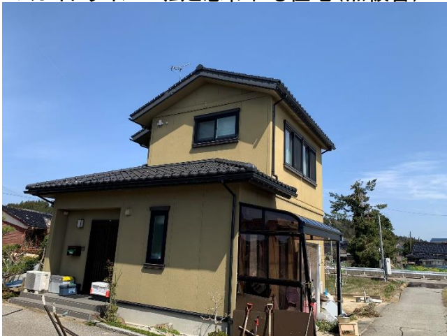
▼ガイドライン工法と思われる住宅(無被害)
